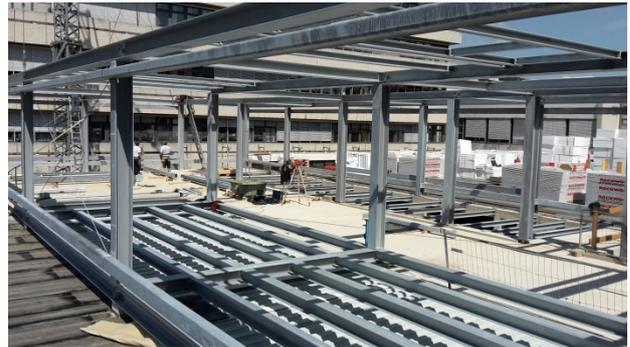
Bild 2 – Stahlkonstruktion Technikzentrale
